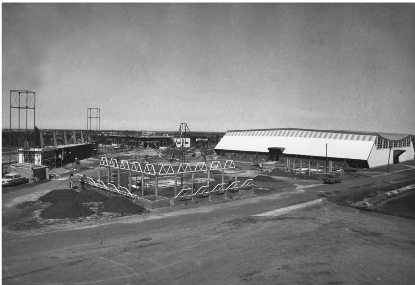
Avances en las obras
