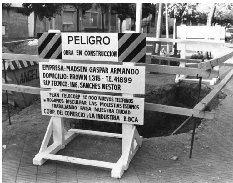
TeleCorp '85. 10.000 teléfonos para la ciudad. Cartel de obra.
