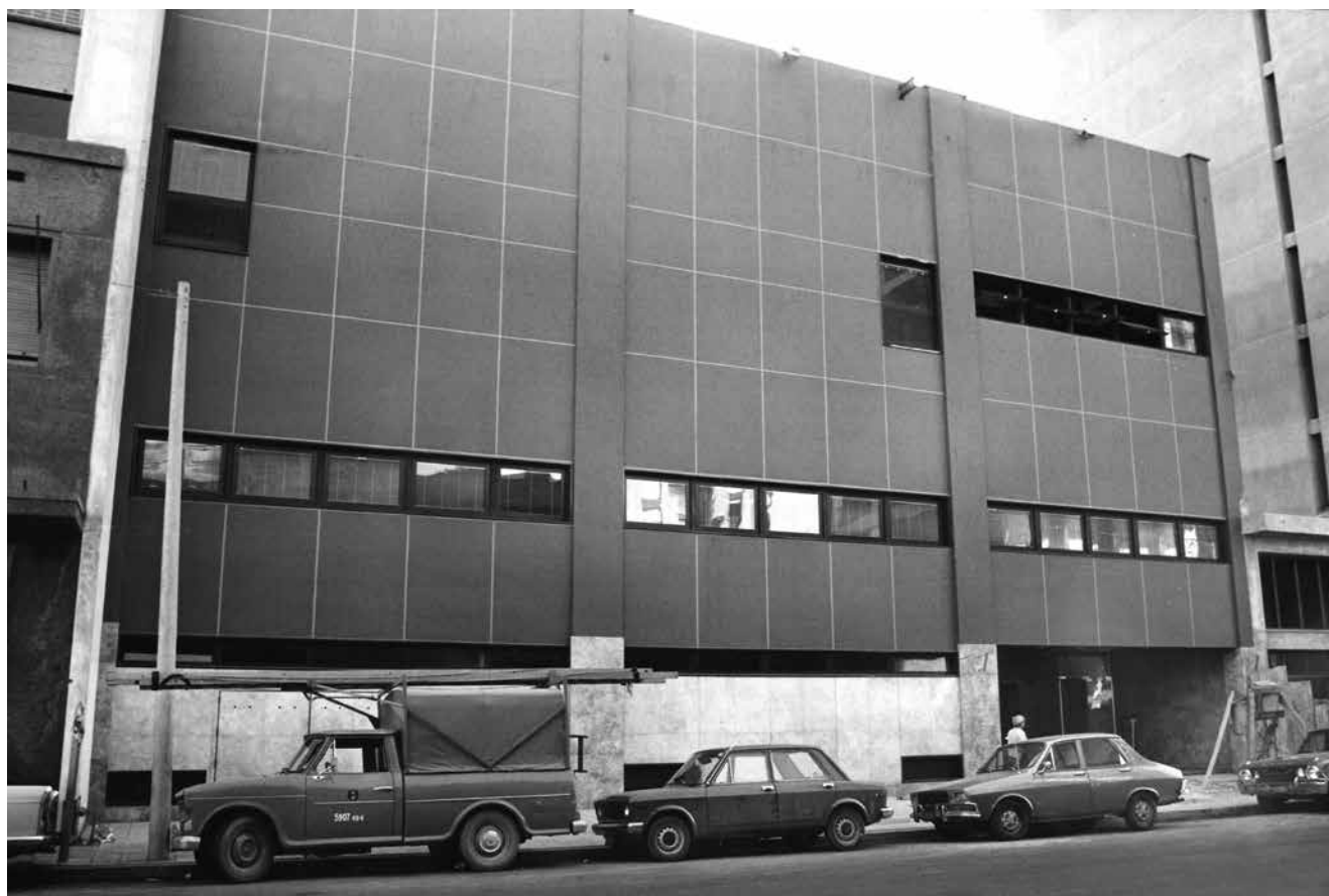
Edificio Central Telefónica – Beruti 62.
