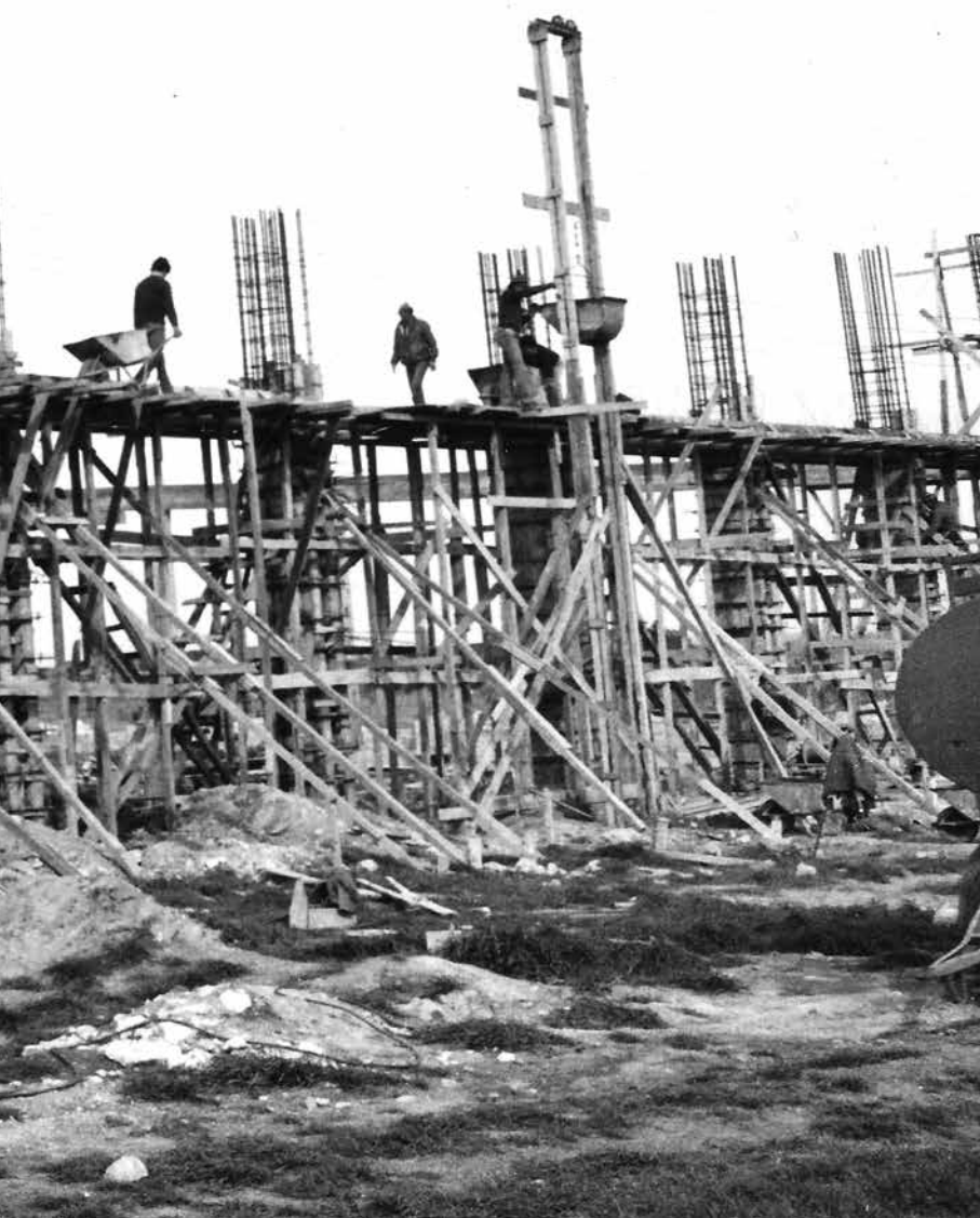
Predio ferial en construcción.
