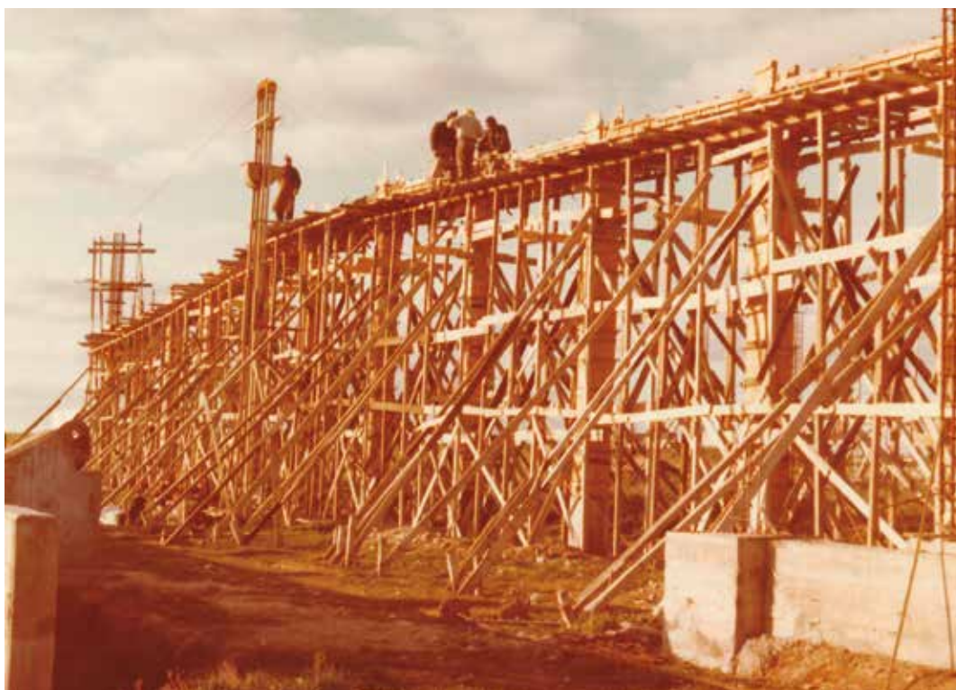
Predio ferial en construcción. 20 de octubre de 1982
