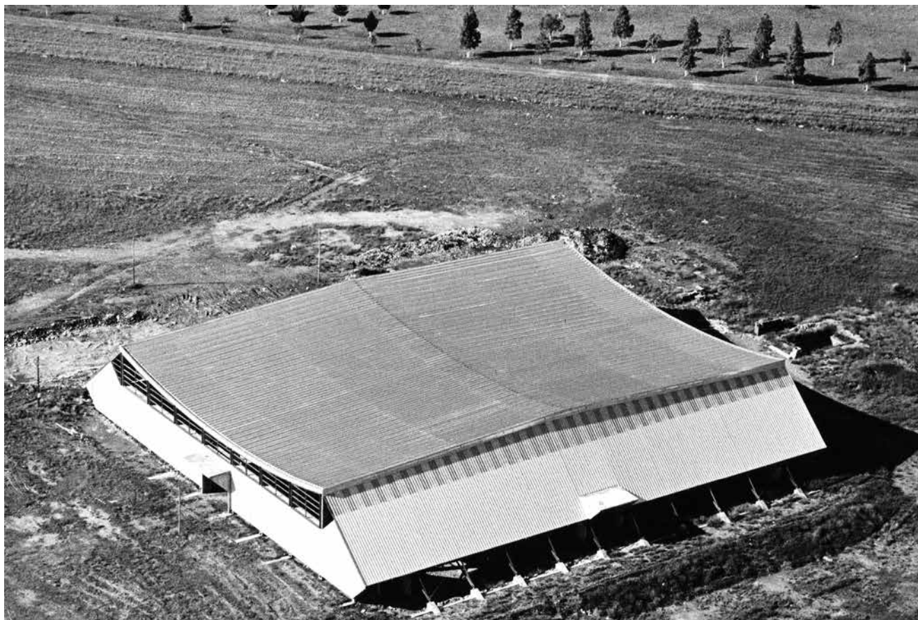
Pabellón central terminado - 3 de junio de 1983.
