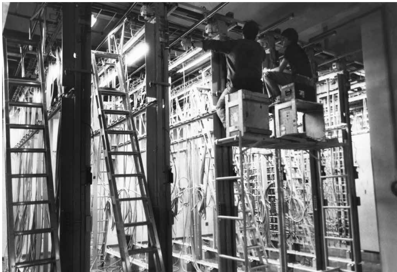
Trabajos en la Central.
